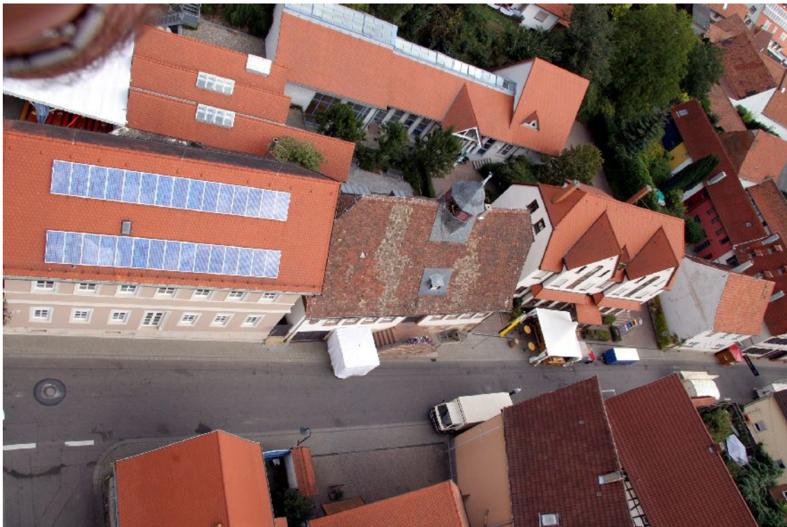
Die Fotovoltaikanlage auf der Grundschule Insheim
