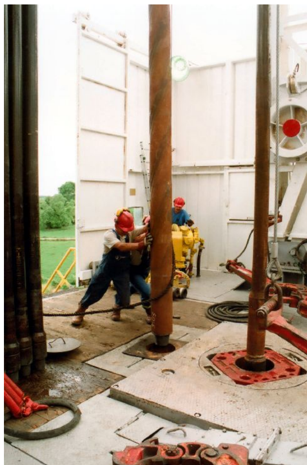
Das erste Bohrgestänge wird eingesetzt
