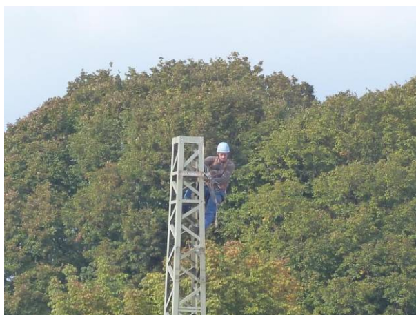
Bilder vom Abbau des Gittermastes in der Sportplatzstraße
