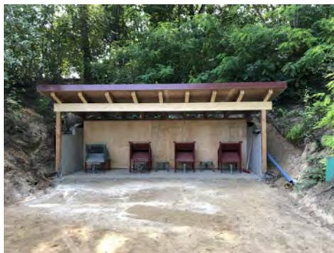
Der Einsatz eines Baggers hätte wohl hier den Kostenrahmen gesprengt. Unabdingbar war aber ein Autokran. Mit ihm konnten nun die tonnenschweren L-Steine, Schotter- und Pflastersteine und das Konstruktionsholz für das Dach auf die 50-m-Schießbahn, hinter dem Clubhaus, gesetzt werden. Auch das Coronavirus konnte die Baumaßnahme nicht stoppen (Beginn: März 2020), so dass im September 2020 die Abnahme durch den Schießstand-Sachverständigen erfolgte.
