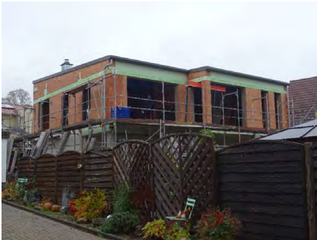
Nach Beendigung der Rohbauarbeiten
